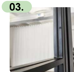
03. Rahmen mit Schrauben befestigt
