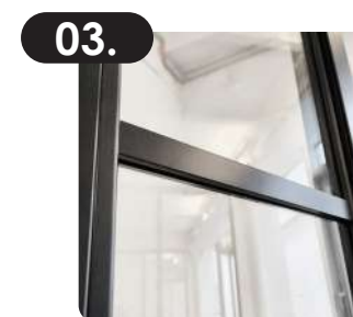
03. Geklebte Sprossen 5 mm x 25 mm
