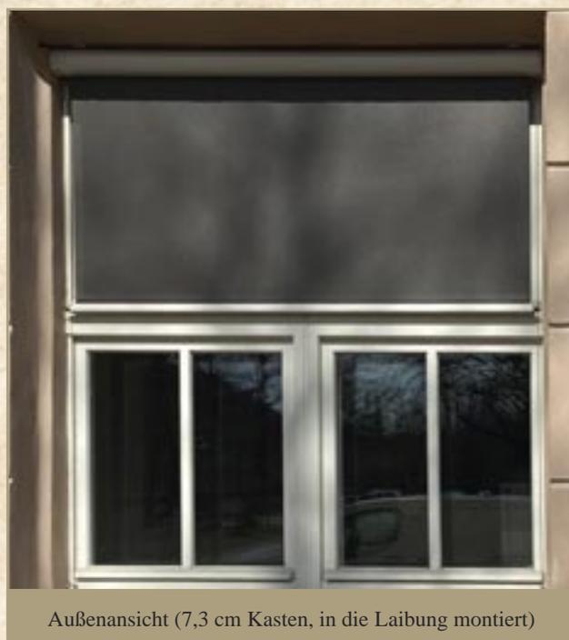
Außenansicht (7,3 cm Kasten, in die Laibung montiert)
